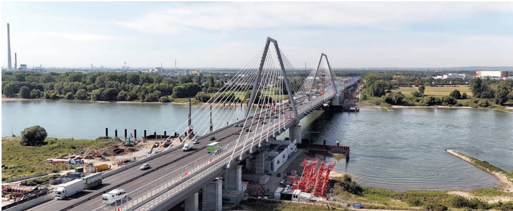
Die neue Rheinbrücke Leverkusen.
