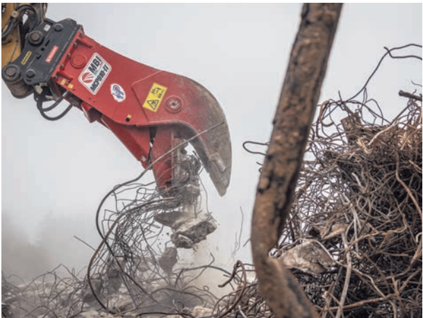
Geprüfte Abbruchbaggerfahrer lernen: Zur Verfügung stehen eine Abbruchschere vom Typ CC35R, ein drehbarer Pulverisierer RP30-IT, ein Haufwerkspulverisierer MCP910-IT sowie ein Abbruch- und Sortiergreifer MSG1000R.
