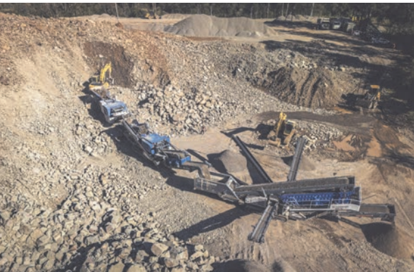
Neuanschaffungen angeht, definitiv weiter im Wirtgen Group-Universum bewegen«, ist Douglas Matt überzeugt. Er lobt die Flexibilität, die Effizienz und die leichte Bedienbarkeit, das alles habe die Nutzer bei der Ciber Anlage schon immer begeistert. Es sei ein echter Fortschritt für die Beteiligten, dass diese Vorteile mit dem neuen Anlagenzug von Kleemann jetzt auch in der Materialaufbereitung zu nutzen seien. Foto: Wirtgen Group
