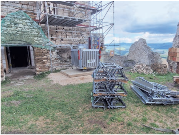
Für die Renovierungsarbeiten an der Zipser Burg kommt ein Aufzug vom Typ 500 Z/ZP zum Einsatz.
