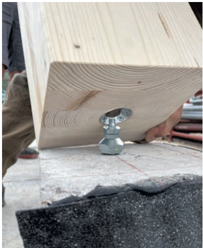
Die Verbindung von Wand und Boden auf der Baustelle gelingt mit Modulix schnell und einfach, versichert Sihga.
