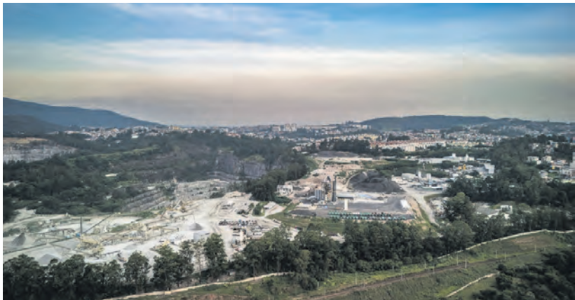
Die RPP-Anlage von Benninghoven fügt sich optimal in den Steinbruch zwischen der Aufbereitung des Weißmaterials und der Recycling-Deponie ein.
