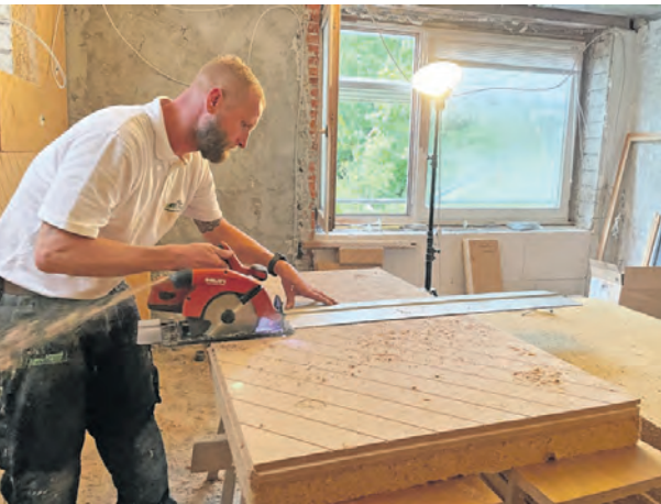
Die Holzfaserplatten lassen sich leicht zuschneiden. Es gibt sie in Dämmstärken von 80 bis 200 mm.
