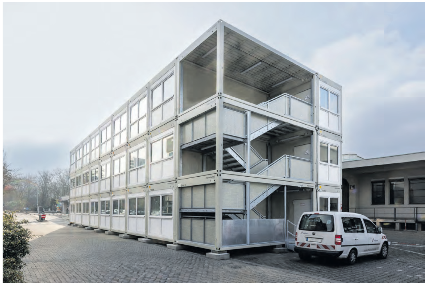
SANIERUNG VON NACHWUCHSZENTRUM
