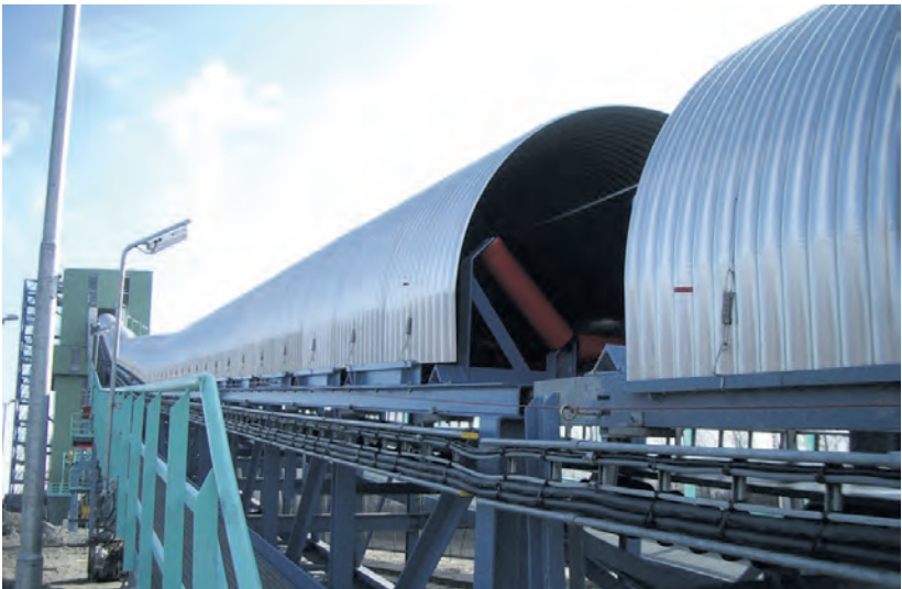
Im Bild die beidseitig zu öffnende LOOP-Haube im Einsatz vor Ort.
