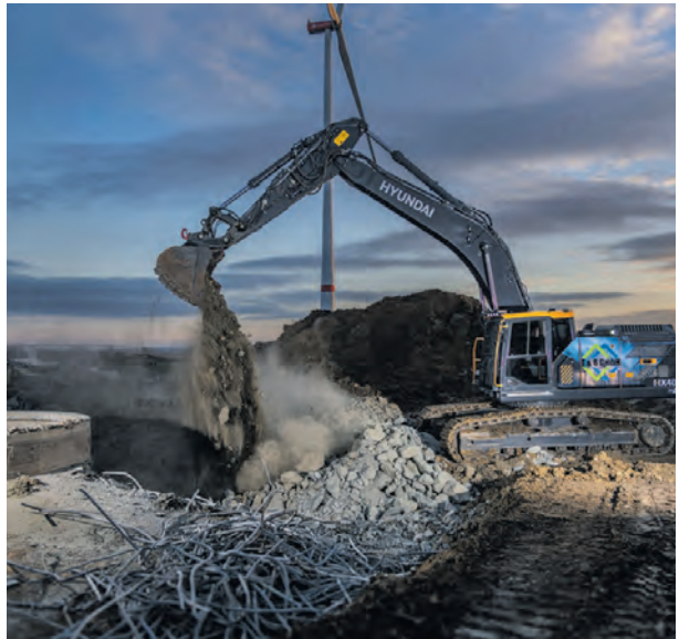
Der rund 40 t schwere HX400L wird von einem Hyundai-DX08-Dieselmotor angetrieben.
