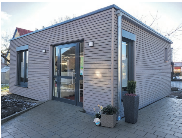
Moderner Friseursalon »Haarmonie« in Hybrid-Modulbauweise von Heinkel Modulbau mit Fassade aus Lärchenholz im Finkenweg in Neu-Ulm/Burlafingen.
