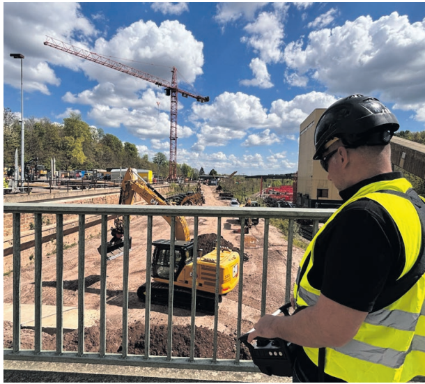
Sämtliche Arbeitsbefehle werden per Funk in Echtzeit an die Maschine übermittelt.
