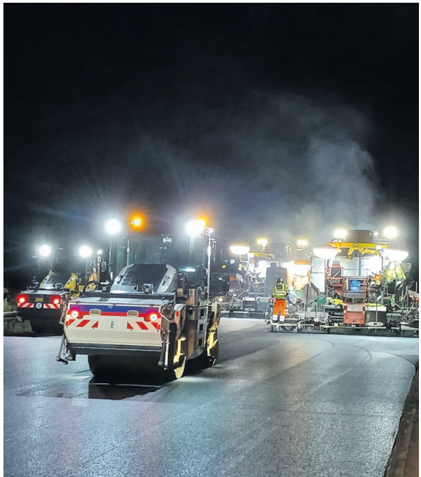
Aufgrund der äußerst engen Zeitfenster von lediglich sechs Tagen je Richtungsfahrbahn wurde im Mehrschichtbetrieb gearbeitet.
