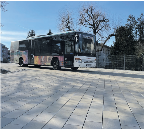
Insbesondere in den Kreuzungsbereichen wirken die Fahrzeuge oft mit besonderen Schub- und Scherkräften auf die Flächen ein.
