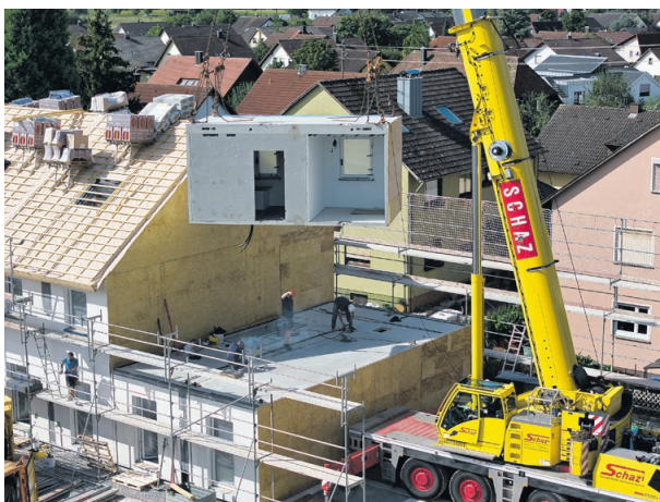
Trotz estrichfreier Ausführung erreichen die Module den erhöhten Schallschutz-Standard nach DIN 4109-2015.
