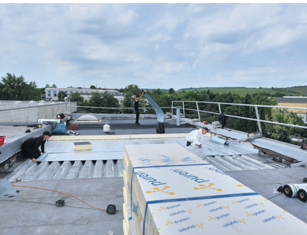
Sanierungsarbeiten auf dem Dach des Verwaltungsbaus der Weinkellerei Reh Kendermann in Bingen.
