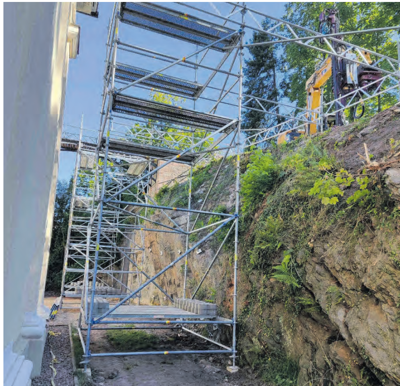
Lastableitende, ballastierte Stütztürme aus ALFIX MODUL MULTI 4.0 höhenvariabel angepasst an das jeweilige Geländeprofil.
