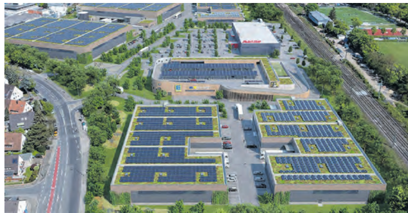
Im westlichen Stadtgebiet von Nürnberg entsteht bis 2027 im Auftrag von Union Investment ein Mischnutzungsquartier mit rund 41.400 m² Nutzfläche.
