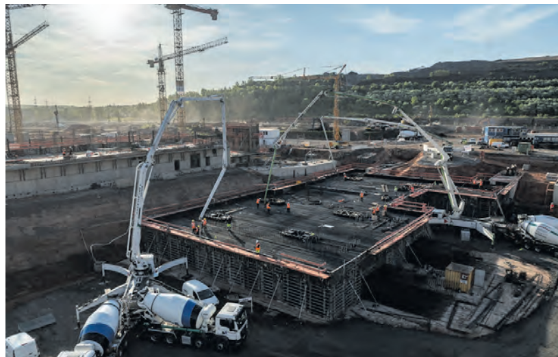
Großbetonagen stellen besondere Anforderungen an die Organisation der Baustelle.
