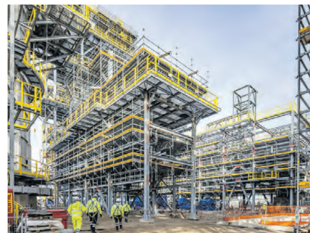
Die Erweiterung der Biokraftstoffraffinerie in Rotterdam wurde mithilfe von mehr als 30.000 m² PERI UP-Modulgerüst erfolgreich umgesetzt.
