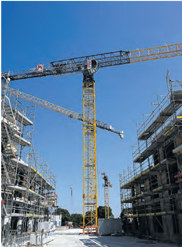
Das Team von BKL München montiert die drei Turmdrehkrane auf Anker.
