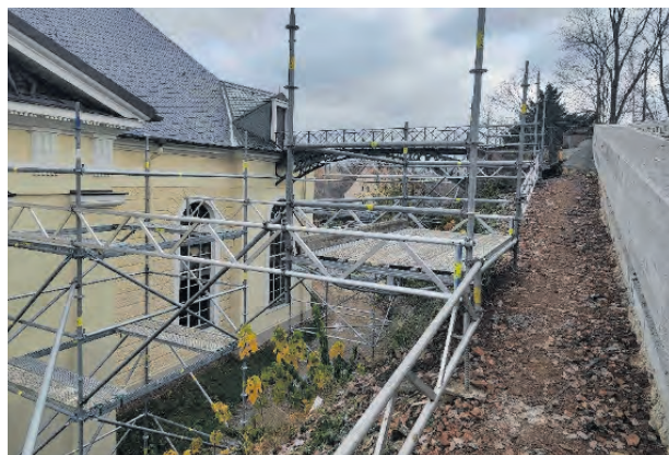
Absturzsicherung aus ALFIX MODUL MULTI 4.0 in Verbindung mit systemfreien Gitterträgern.
