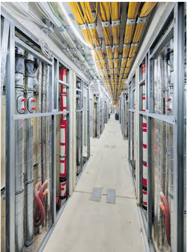
Unmittelbar nach der Dämmung aller Leitungen wurden diese mit Schachtwänden in Trockenbauweise verkleidet.
