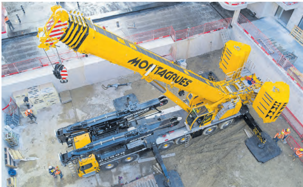
Millimeterarbeit: Die Stellflächen auf der Baustelle waren extrem begrenzt.
