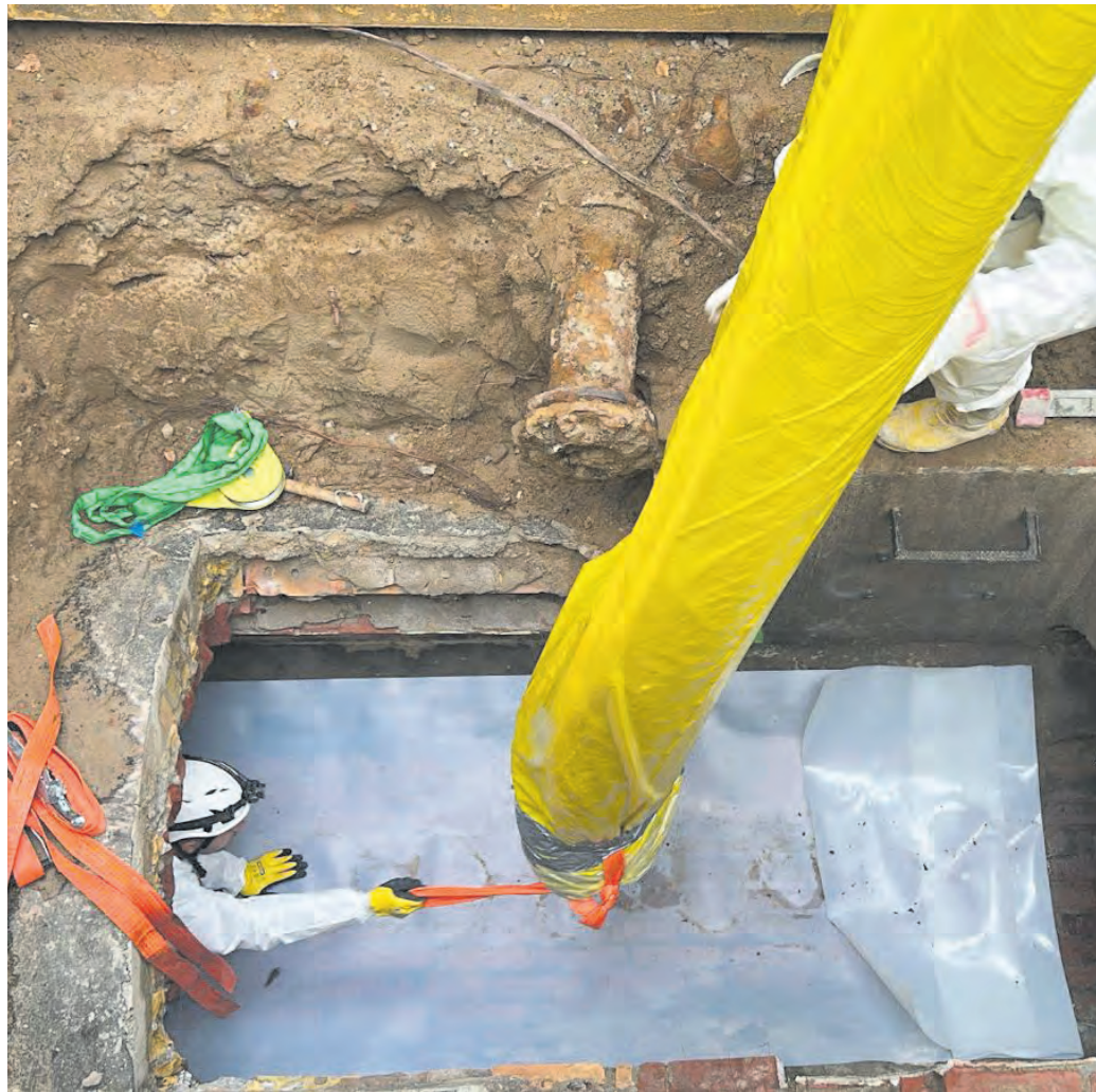
Hier wird der Liner eingezogen.
