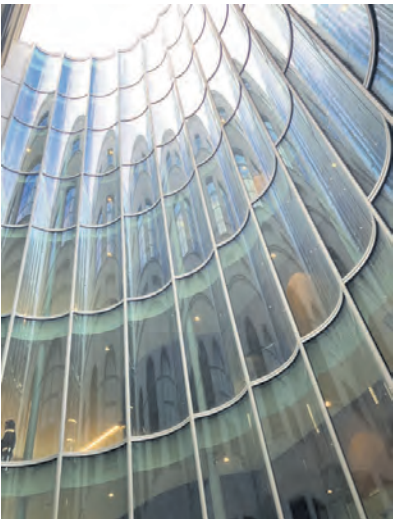
Die gebogenen Isoliergläser werden auf jeder Etage von Querstreben aus lackiertem, geschweißtem Stahl mit T-Profil gehalten
