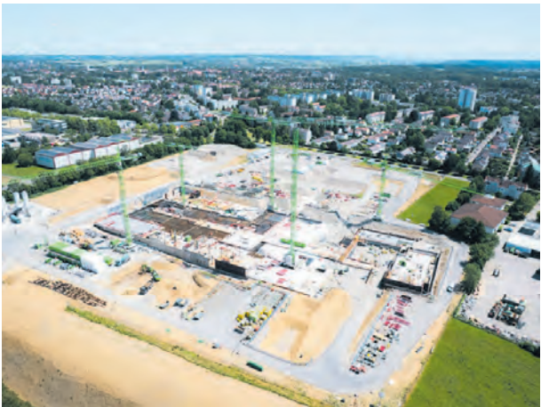
Fünf von sechs Kranen von Wolffkran sind aktuell auf der Memminger Baustelle im Einsatz.
