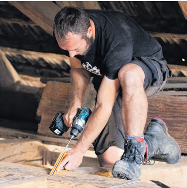
Die Schrauben können im 45°-Winkel angesetzt und verschraubt werden.
