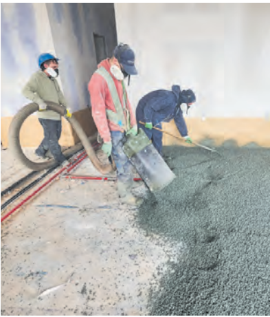
Prefab Silent Floor bildet eine elastische Zwischenschicht.
