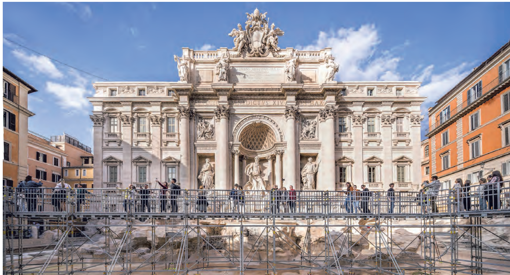
Die Zugangs- lösung , be- stehend aus PERI UP-Modulgerüst und der PERI UP Public-Treppe, er- möglichte den Be- suchern einen ein- zigartigen Blick auf das barocke Kulturdenkmal.
