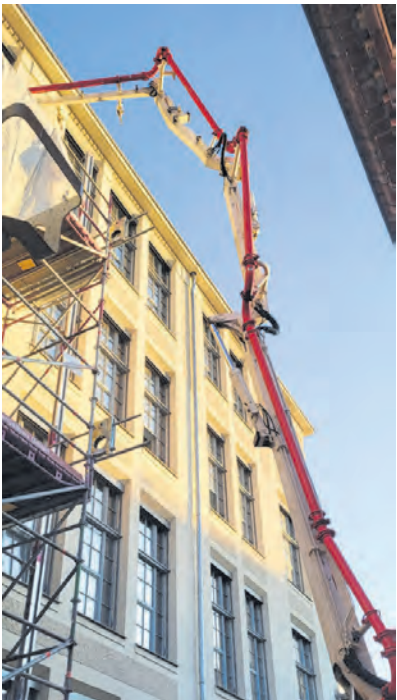
Dank Stahlrohrleitung und spezieller Rezeptur ließ sich der Liapor-Leichtbeton rund 100 m weit ins Gebäude pumpen.
