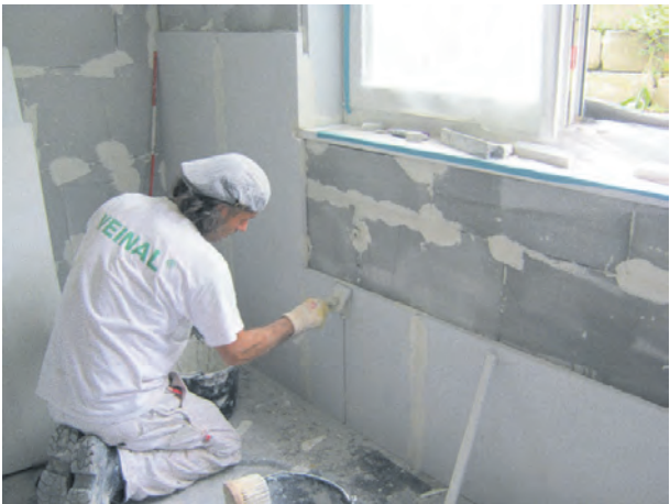
Nach der Trockenlegung empfiehlt der Hersteller eine ergänzende Abdichtung.
