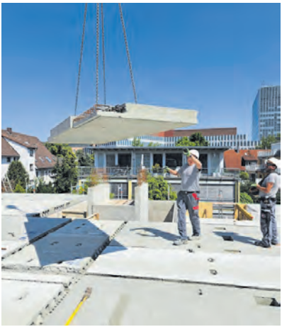
Die Deckenelemente werden per Kran platziert, justiert und verschraubt.
