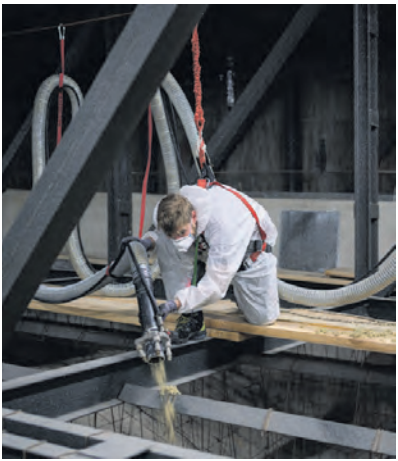
Das nichtbrennbare Steinwolle-Granu-lat wurde durch Shläuche gefördert.
