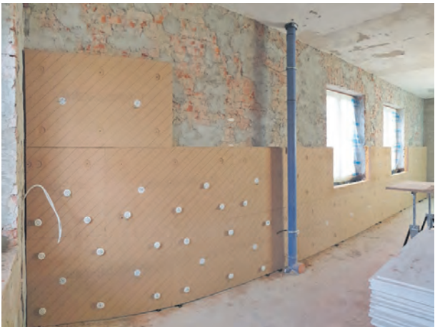
Insgesamt sind laut Hersteller etwa 500 m² Holzfaser-Dämmplatten verbaut worden.
