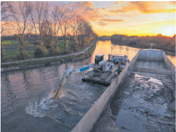
Ghent Dredging hat sich vornehmlich auf Nassbaggerarbeiten spezialisiert.
