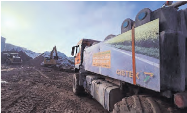
Durch die alternative Herangehensweise in der Bodenverdichtung kann Material gespart werden.
