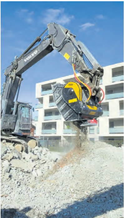
Abbruchunternehmen können Armierungseisen direkt auf der Baustelle aus Stahlbeton zurückgewinnen.
