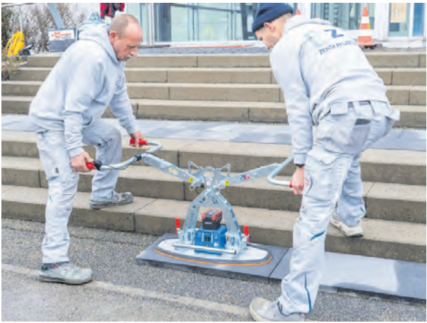
M-JET-250 Vakuum-Handverlegegerät im Einsatz auf der Baustelle.
