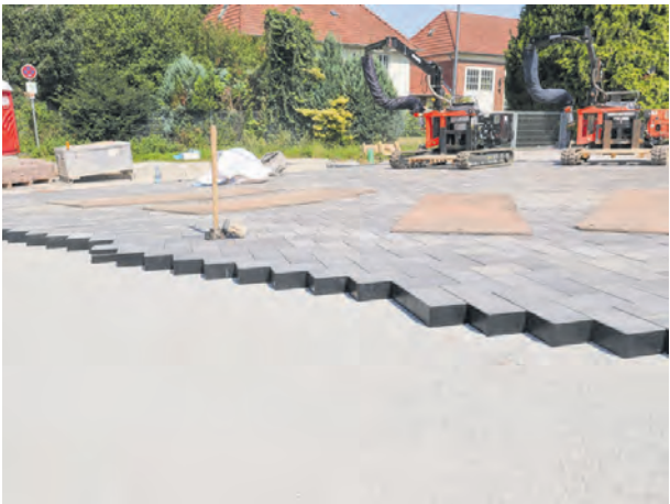
Das Gesamtkonzept umfasste unter anderem die Erneuerung der Anfahrtswege und Parkplätze vor dem Zentrum.
