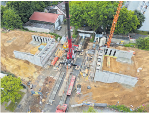
Eine Schlüsselrolle spielte die sogenannte Echterhoff-Expressbauweise beim Brückenbauwerk über die Euskirchener Straße.
