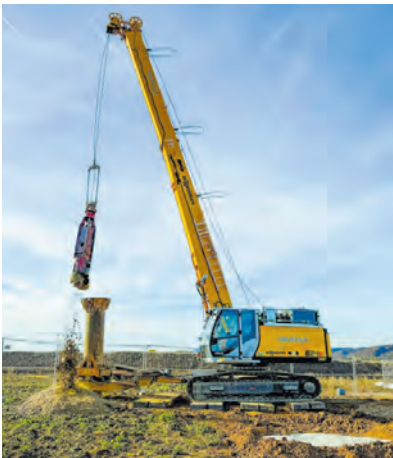
Der Greifer wird angebaut, um das Bodenmaterial auszubaggern.
