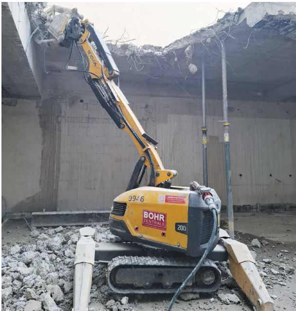
Der Brokk 200 – ein Abbruchroboter – ist im ehemaligen Volksbankareal bei der Arbeit.
