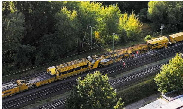
Mit dem neuen Umbauzug von Matisa investiert Leonhard Weiss in die Zukunft der maschinellen Gleiserneuerung.
