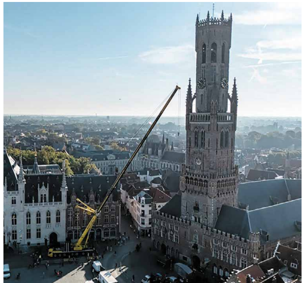
Der belgische Krandienstleister Gheysens setzte laut eigener Aussage in Brügge auf einen Tadano AC 7.450-1, dessen große Reichweite und kompakte Bauweise optimale Voraussetzungen für die Aufgabe boten.
