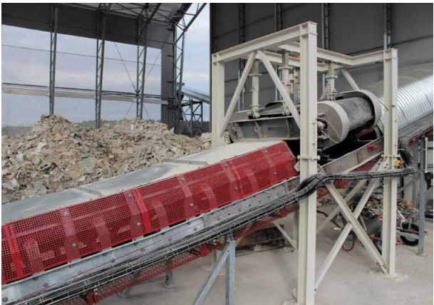
Blick in eine Recyclinganlage . Die Mengen steigen, aber die Potentiale werden nicht ausgeschöpft.
