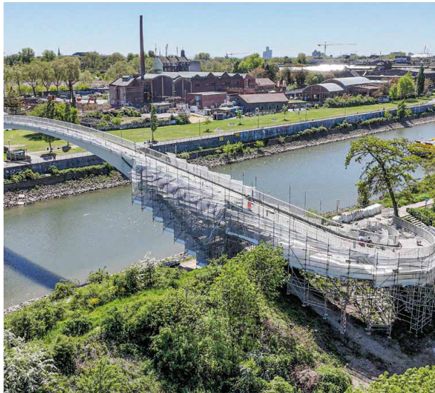
Für die Sanierung der Brücke setzte Odendahl Gerüstbau 50 t RINGSCAFF Modulgerüst als Stand- und als Hängegerüst ein.
