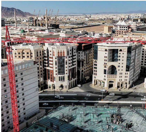
Für die Hebearbeiten am Bau eines neuen Hotelprojekts in Al Madinah ist Wolffkran Saudi Arabia beteiligt.
