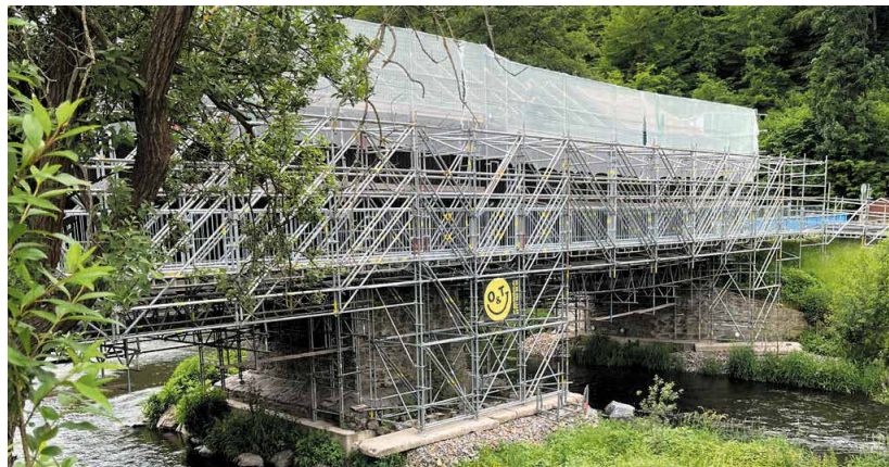
Die Fußgängerbrücke besteht ALFIX MODUL METRIC 4.0 mit doppelt ausgeführten Vertikalstielen und zugehörigen Diagonalen.
