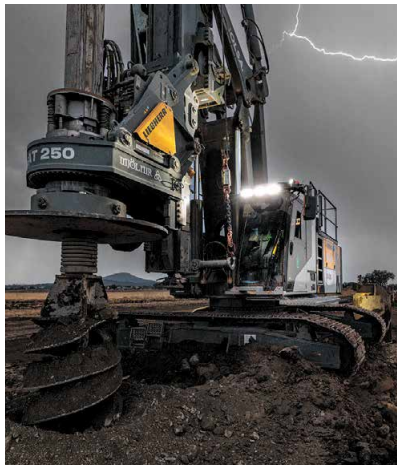
Die Maschine kommt nahe Mexiko-Stadt im Kellybohrverfahren zum Einsatz.
