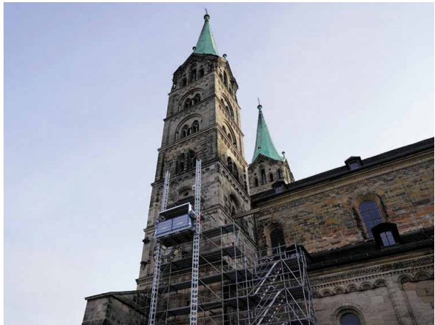
Im Rahmen der fortlaufenden Instandsetzung des Doms saniert die Dombauhütte des Staatlichen Bauamts Bamberg die unteren Geschosse des Nordostturms.
