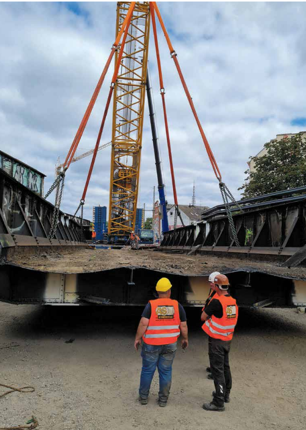
Die Stahlsegmente wurden mit Großkrantechnik ausgehoben und am Boden weiter zerlegt.
