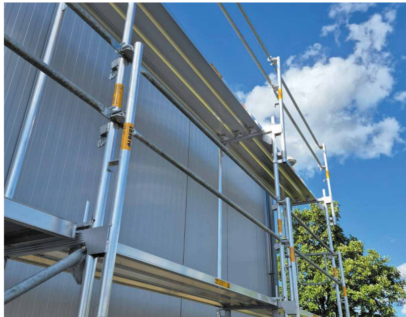
Das VAP-System besteht aus einzelnen VA-Pfosten und metrischen Rückengeländern des Albert-UNITAC-Systems.
