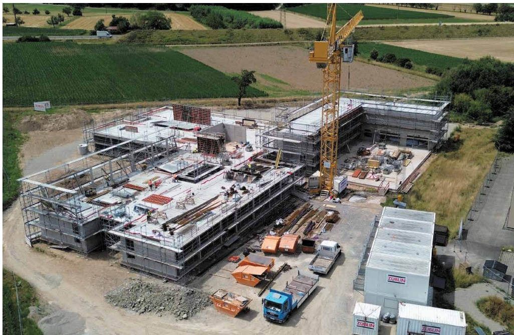
Für den Rohbau der neuen Grundschule in Gengenbach setzte die Ed. Züblin AG auf die Schalungssysteme LOGO.3 und PASCHAL Deck. Die projektbezogene Schalungsplanung von Paschal schuf dabei die Grundlage für die anspruchsvollen Sichtbetonflächen.
